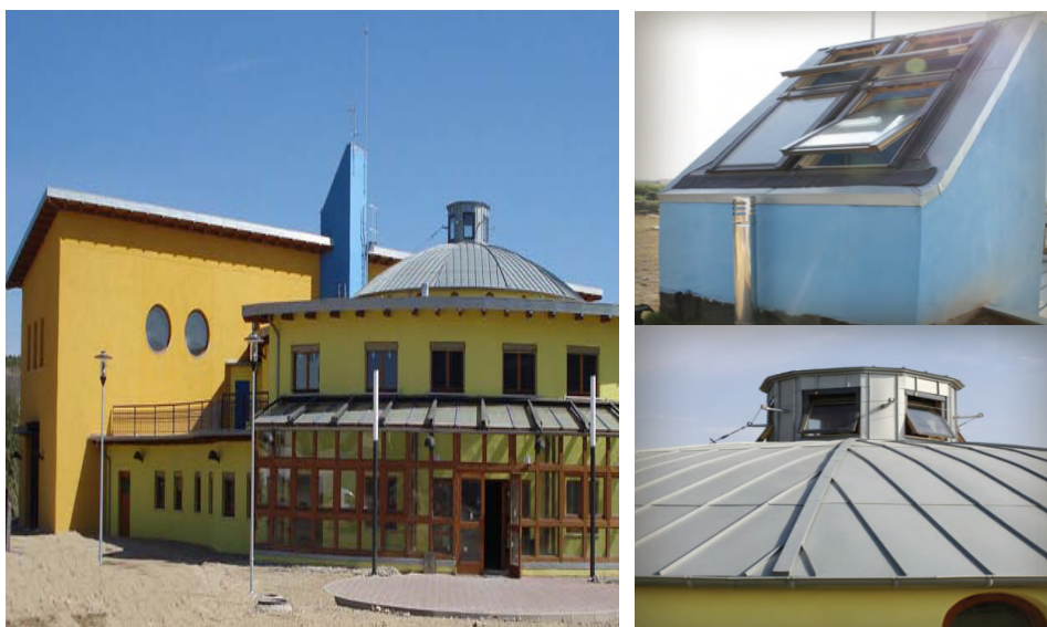
Obrázek č. 14 – Budova CIRCE (vlevo); solární komín a nucená ventilace (vpravo nahoře); sběrník přírodního světla (vpravo dole)
