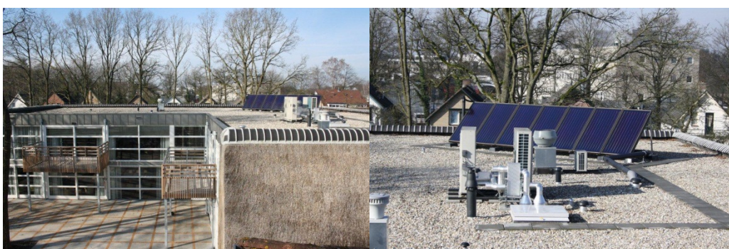
Obrázek č. 5 – Domov Rumah Saya se solárními tepelnými panely a vzdušným tepelným čerpadlem na střeše
