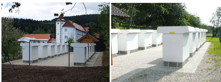
Obrázek č. 13 – Umístění tepelných čerpadel domova pro seniory (vlevo) a přiblížená kaskáda tepelných čerpadel (vpravo)
